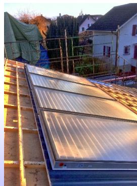
Vue en toiture du champs de capteurs Optisun 250, 20 m 2
