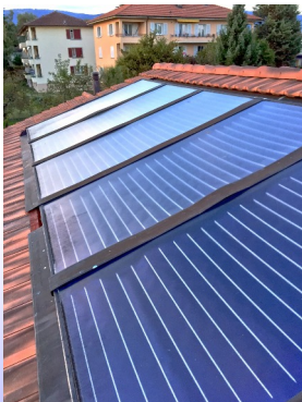
Vue en toiture du champs de capteurs Optisun 250, 20 m 2
