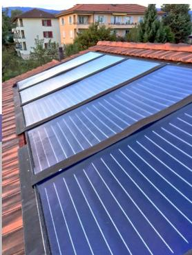
Vue en toiture du champs de capteurs Optisun 250, 20 m<sup>2</sup>
