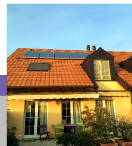
Vue en toiture du champs de 5 capteurs
