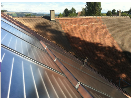
Vue en toiture du champs de capteurs Optisun 250, 20 m 2
