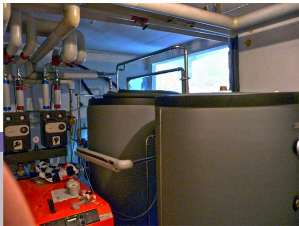
Chaudière avec 2 ballons solaire ECS inox de 800 litres
